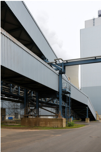
Kraftwerk Neurath (Neuanlage): Entaschungsweg Blöcke F/G - Ascheverladeturm 1, Ansicht von Westen; Foto: 23.10.2023 Fotograf/Urheber: Dr. Norbert Gilson
