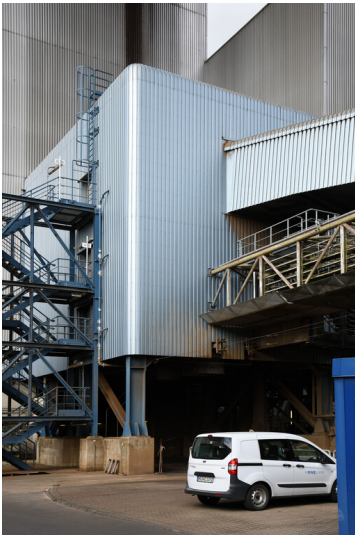
Kraftwerk Neurath: Ascheverladung F/G, Ansicht von Südosten; Foto: 12.09.2023 Fotograf/Urheber: Dr. Norbert Gilson
