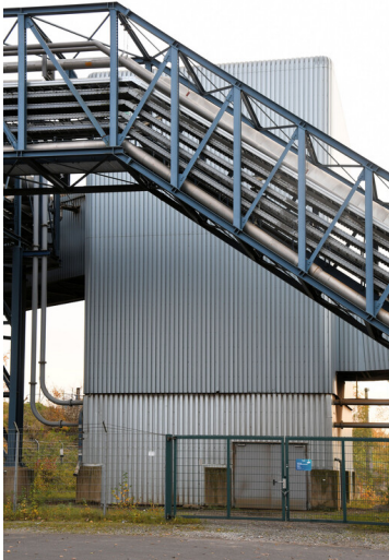
Kraftwerk Neurath (Neuanlage): Ascheverladeturm 2, Ansicht von Norden; Foto: 22.11.2023 Fotograf/Urheber: Dr. Norbert Gilson
