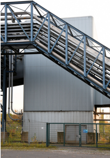
Kraftwerk Neurath (Neuanlage): Ascheverladeturm 2, Ansicht von Norden; Foto: 22.11.2023 Fotograf/Urheber: Dr. Norbert Gilson
