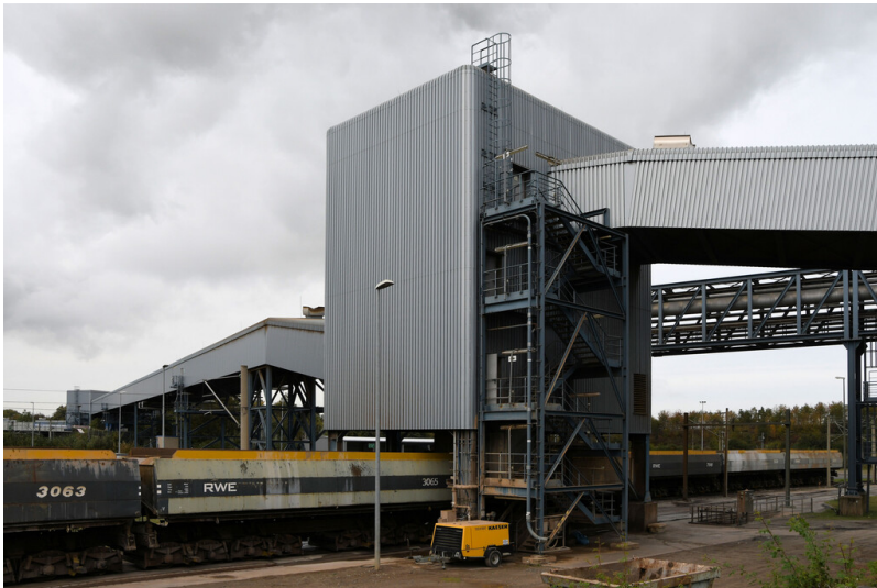
Kraftwerk Neurath (Neuanlage): Ascheverladeturm 1, Ansicht von Süden; Foto: 23.10.2023 Fotograf/Urheber: Dr. Norbert Gilson
