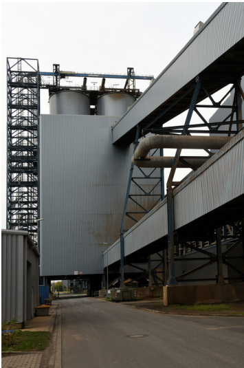
Kraftwerk Neurath (Neuanlage): Nass-/Trockenaschesilos, Einführung der Nassaschebandbrücken, Ansicht von Osten; Foto: 23.10.2023 Fotograf/Urheber: Dr. Norbert Gilson
