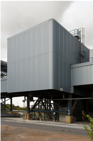
Kraftwerk Neurath (Neuanlage): Gipsverladeturm, Ansicht von Südosten; Foto: 23.10.2023 Fotograf/Urheber: Dr. Norbert Gilson
