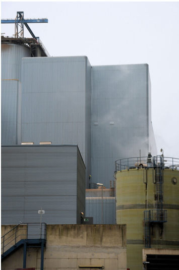
Kraftwerk Neurath (Neuanlage): Gipsentwässerung, Auffangbehälter, Gipsentwässerungsgebäude und Gipslager (im Hintergrund), Ansicht von Osten; Foto: 23.10.2023 Fotograf/Urheber: Dr. Norbert Gilson
