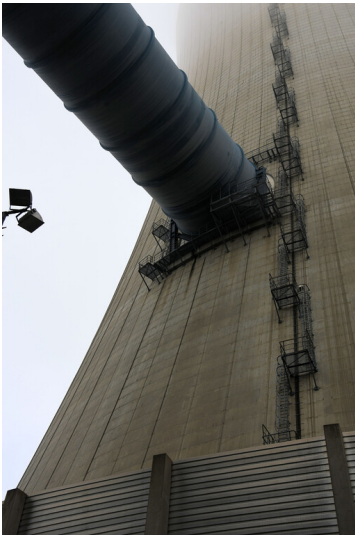
Kraftwerk Neurath (Neuanlage): Reingaseinleitung in den Kühlturm G, Ansicht von Westen; Foto: 23.10.2023 Fotograf/Urheber: Dr. Norbert Gilson
