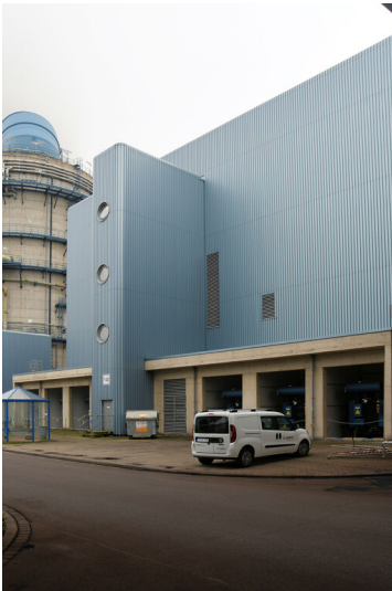
Kraftwerk Neurath (Neuanlage): REA-Schaltanlagegebäude, Ansicht von Nordwesten; Foto: 23.10.2023 Fotograf/Urheber: Dr. Norbert Gilson
