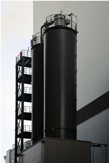
Kraftwerk Neurath (Neuanlage): Quecksilberausscheidung, Reaktionsbehälter, Ansicht von Süden; Foto: 23.10.2023
