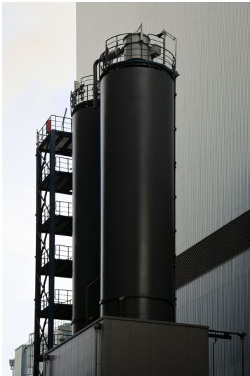
Kraftwerk Neurath (Neuanlage): Quecksilberausscheidung, Reaktionsbehälter, Ansicht von Süden; Foto: 23.10.2023 Fotograf/Urheber: Dr. Norbert Gilson
