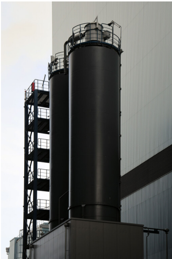
Kraftwerk Neurath (Neuanlage): Quecksilberausscheidung, Reaktionsbehälter, Ansicht von Süden; Foto: 23.10.2023 Fotograf/Urheber: Dr. Norbert Gilson
