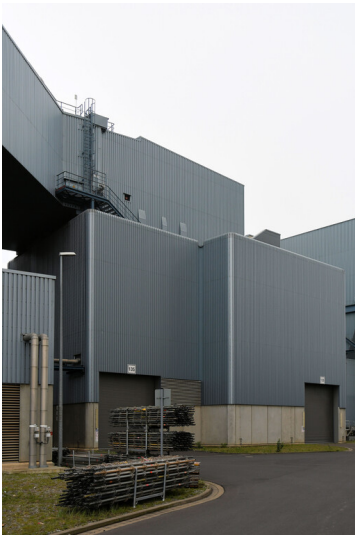
Kraftwerk Neurath (Neuanlage): Saugzuggebäude G2, Ansicht von Südosten; Foto: 23.10.2023 Fotograf/Urheber: Dr. Norbert Gilson
