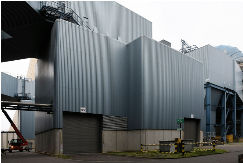
Kraftwerk Neurath (Neuanlage): Saugzuggebäude F2, Ansicht von Südosten; Foto: 23.10.2023 Fotograf/Urheber: Dr. Norbert Gilson
