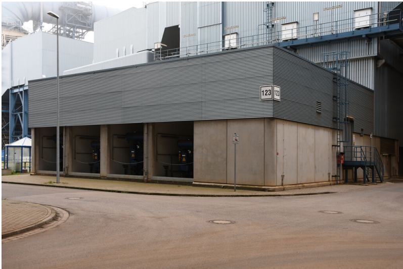
Kraftwerk Neurath (Neuanlage): Schaltanlagegebäude E-Filter Block G, Ansicht von Südwesten; Foto: 23.10.2023 Fotograf/Urheber: Dr. Norbert Gilson
