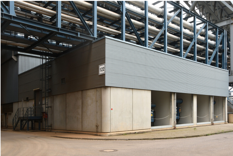
Kraftwerk Neurath (Neuanlage): Schaltanlagegebäude E-Filter Block F, Ansicht von Südosten; Foto: 23.10.2023 Fotograf/Urheber: Dr. Norbert Gilson
