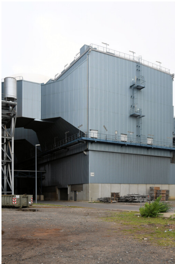
Kraftwerk Neurath (Neuanlage): Elektrofilter Block G, Ansicht von Südosten; Foto: 23.10.2023 Fotograf/Urheber: Dr. Norbert Gilson
