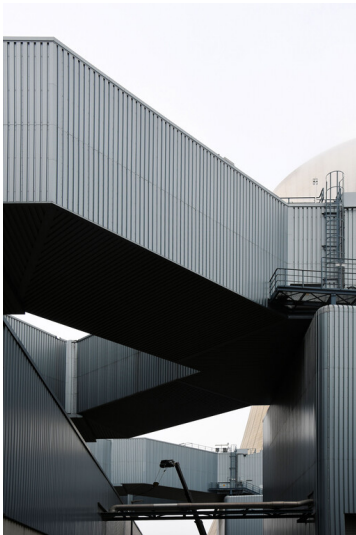
Kraftwerk Neurath (Neuanlage): Elektrofilter Block F, Rauchgaskanäle zu den Saugzügen, Ansicht von Osten; Foto: 23.10.2023 Fotograf/Urheber: Dr. Norbert Gilson
