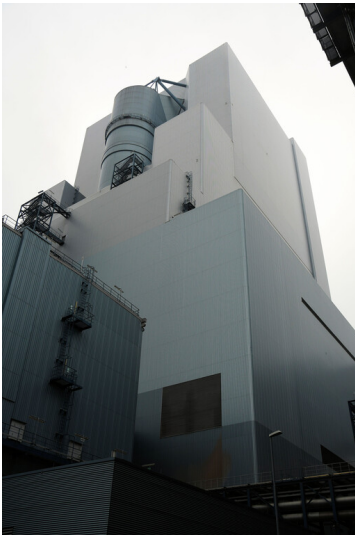
Kraftwerk Neurath (Neuanlage): Kesselhaus Block G, Ansicht von Nordwesten; Foto: 23.10.2023 Fotograf/Urheber: Dr. Norbert Gilson
