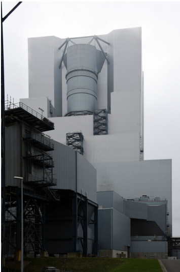
Kraftwerk Neurath (Neuanlage): Kesselhaus Block F, Rauchgasleerzug, Ansicht von Norden; Foto: 23.10.2023 Fotograf/Urheber: Dr. Norbert Gilson
