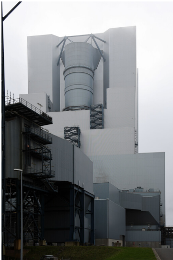
Kraftwerk Neurath (Neuanlage): Kesselhaus Block F, Rauchgasleerzug, Ansicht von Norden; Foto: 23.10.2023 Fotograf/Urheber: Dr. Norbert Gilson
