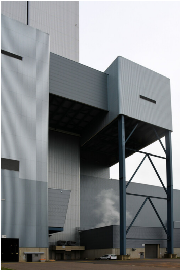
Kraftwerk Neurath (Neuanlage): Zwischenbau Block F, Westteil mit Abstützung, Ansicht von Nordwesten; Foto: 23.10.2023 Fotograf/Urheber: Dr. Norbert Gilson
