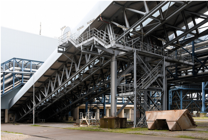
Kraftwerk Neurath (Neuanlage): Bekohlungsbandbrücken vom Brechergebäude zum Zwischenbau Block F, Ansicht von Süden; Foto: 23.10.2023 Fotograf/Urheber: Dr. Norbert Gilson
