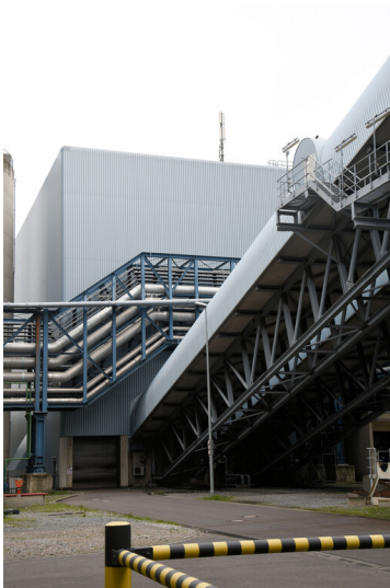
Kraftwerk Neurath (Neuanlage): Brechergebäude Kohleaufbereitung, Bekohlungsbandbrücke zum Zwischenbau Block F, Ansicht von Süden; Foto: 23.10.2023 Fotograf/Urheber: Dr. Norbert Gilson
