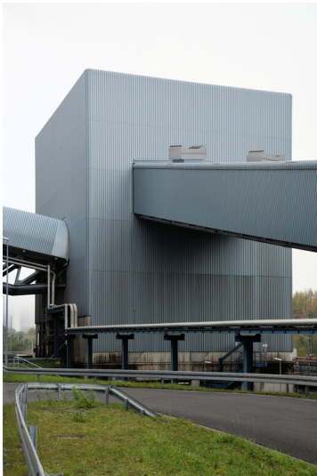
Kraftwerk Neurath (Neuanlage): Eisenaushaltung (Eisenausscheidung), Ansicht von Südosten; Foto: 23.10.2023 Fotograf/Urheber: Dr. Norbert Gilson
