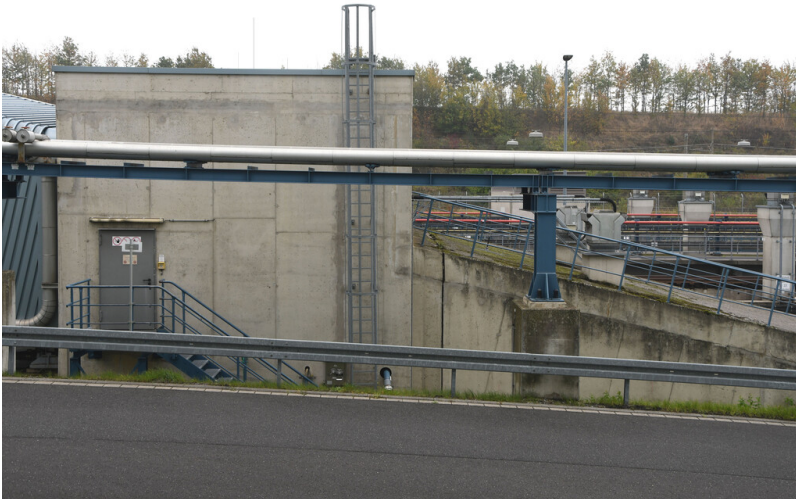
Kraftwerk Neurath (Neuanlage): Kanal zur Eisenaushaltung, Ansicht von Süden; Foto: 23.10.2023 Fotograf/Urheber: Dr. Norbert Gilson
