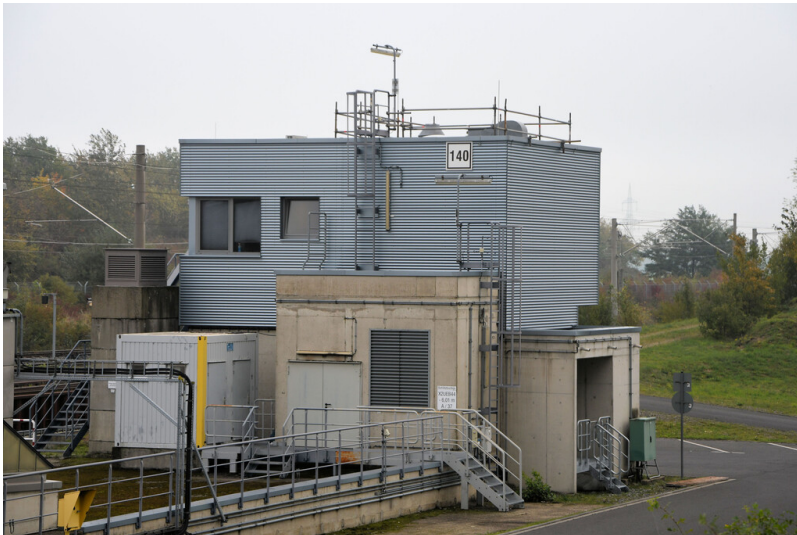
Kraftwerk Neurath (Neuanlage): Kohleverteilgebäude Schlitzbunker, Ansicht von Südwesten; Foto: 23.10.2023 Fotograf/Urheber: Dr. Norbert Gilson
