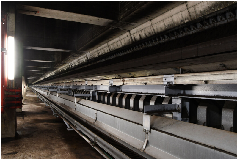
Kraftwerk Neurath (Neuanlage): Schlitzbunker, Bunkerschiff mit Kohleabzugsband, Innenansicht; Foto: 23.10.2023 Fotograf/Urheber: Dr. Norbert Gilson
