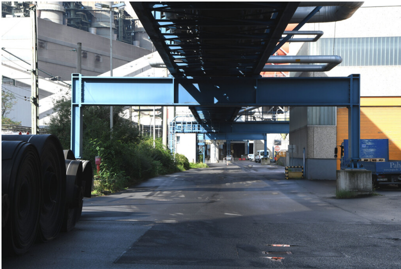
Kraftwerk Neurath: Lagerstraße, Ansicht von Osten; Foto: 12.09.2023 Fotograf/Urheber: Dr. Norbert Gilson
