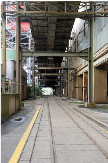
Kraftwerk Neurath: Aschestraße, Verlauf in Höhe der Zündölanlage, Ansicht von Westen; Foto: 12.09.2023 Fotograf/Urheber: Dr. Norbert Gilson
