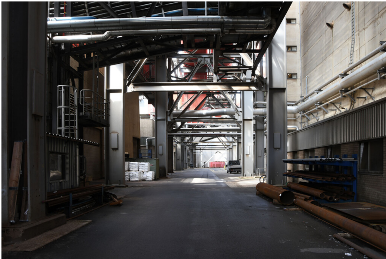
Kraftwerk Neurath: Kaminstraße, Ansicht von Osten; Foto: 12.09.2023 Fotograf/Urheber: Dr. Norbert Gilson
