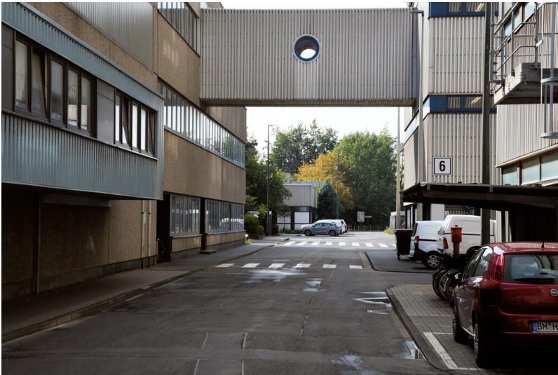
Kraftwerk Neurath: Brecherstraße, Ansicht von Norden; Foto: 12.09.2023 Fotograf/Urheber: Dr. Norbert Gilson
