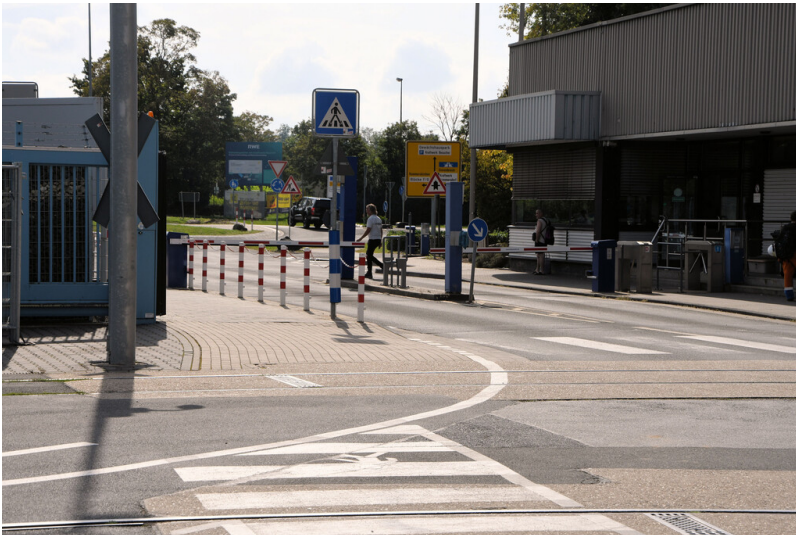
Kraftwerk Neurath: Kraftwerkszufahrt, Ansicht von Nordosten; Foto: 12.09.2023 Fotograf/Urheber: Dr. Norbert Gilson
