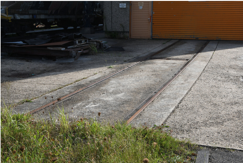
Kraftwerk Neurath: Zufahrtsgleis zum Lokschuppen, erhaltener Abschnitt vor der Lokschuppeneinfahrt, Ansicht von Westen; Foto: 12.09.2023 Fotograf/Urheber: Dr. Norbert Gilson
