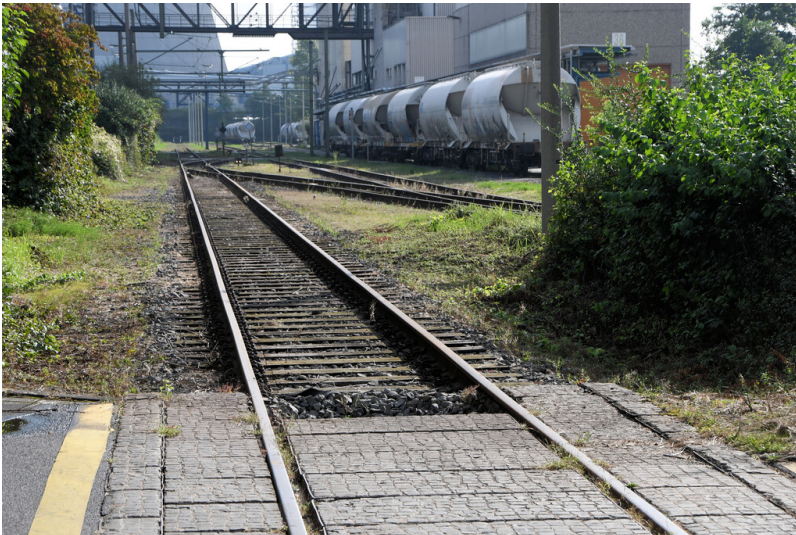
Kraftwerk Neurath: Aschetransportgleis, Verzweigung in Höhe des Kalkbahnhofs, Ansicht von Westen; Foto: 12.09.2023 Fotograf/Urheber: Dr. Norbert Gilson
