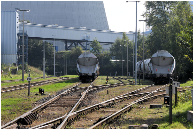
Kraftwerk Neurath: Rückstoßgleise vom Kalkgleis als Rangier- und Abstellgleise für die Kalkwaggons, Ansicht von Westen; Foto: 12.09.2023 Fotograf/Urheber: Dr. Norbert Gilson
