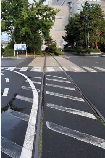
Kraftwerk Neurath: Maschinenhausgleis, Kreuzung der Hauptstraße, Ansicht von Osten; Foto: 12.09.2023 Fotograf/Urheber: Dr. Norbert Gilson
