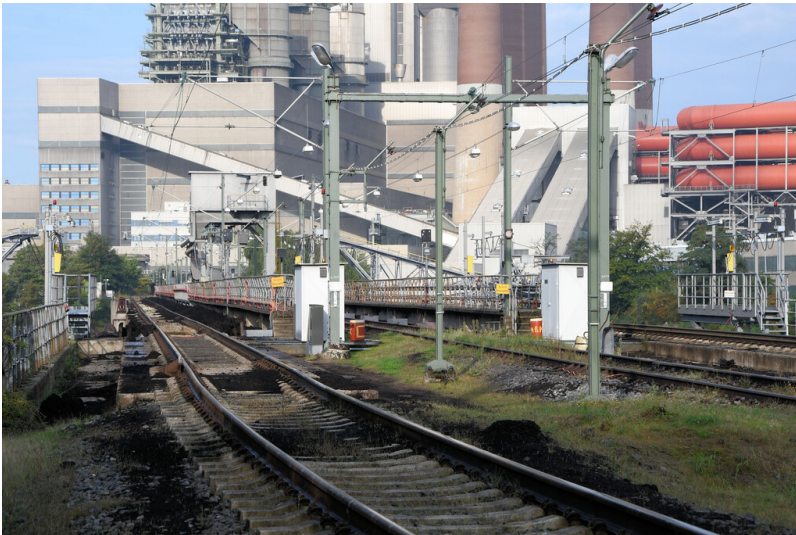
Kraftwerk Neurath: Bunkergleise, südliches Bunkergleis, Ansicht von Osten; Foto: 12.09.2023 Fotograf/Urheber: Dr. Norbert Gilson
