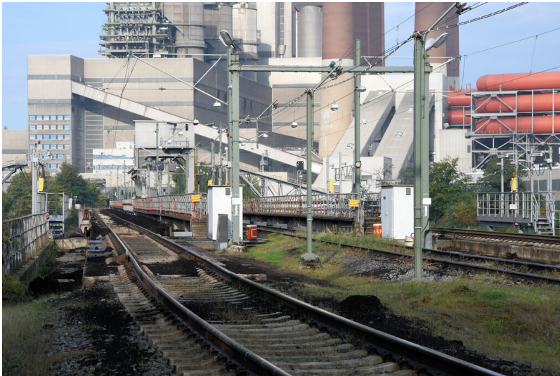
Kraftwerk Neurath: Bunkergleise, südliches Bunkergleis, Ansicht von Osten; Foto: 12.09.2023 Fotograf/Urheber: Dr. Norbert Gilson
