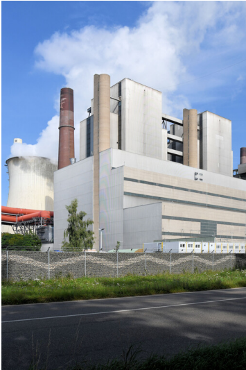
Kraftwerk Neurath: Treppen- und Aufzugtürme mit den Kesselhäusern der Blöcke D (rechts) und E, Ansicht von Südwesten; Foto: 12.09.2023 Fotograf/Urheber: Dr. Norbert Gilson
