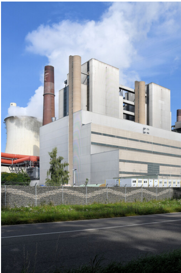
Kraftwerk Neurath: Treppen- und Aufzugtürme mit den Kesselhäusern der Blöcke D (rechts) und E, Ansicht von Südwesten; Foto: 12.09.2023 Fotograf/Urheber: Dr. Norbert Gilson
