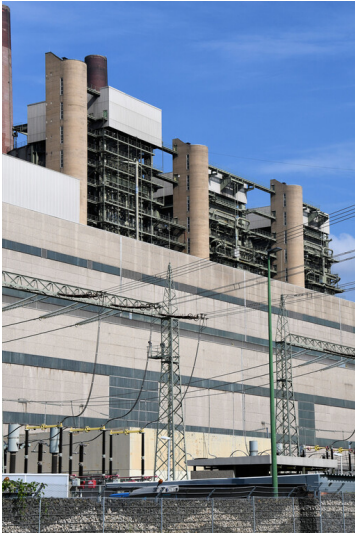
Kraftwerk Neurath: Treppen- und Aufzugtürme der Blöcke A (rechts), B und C, Ansicht von Südwesten; Foto: 12.09.2023 Fotograf/Urheber: Dr. Norbert Gilson
