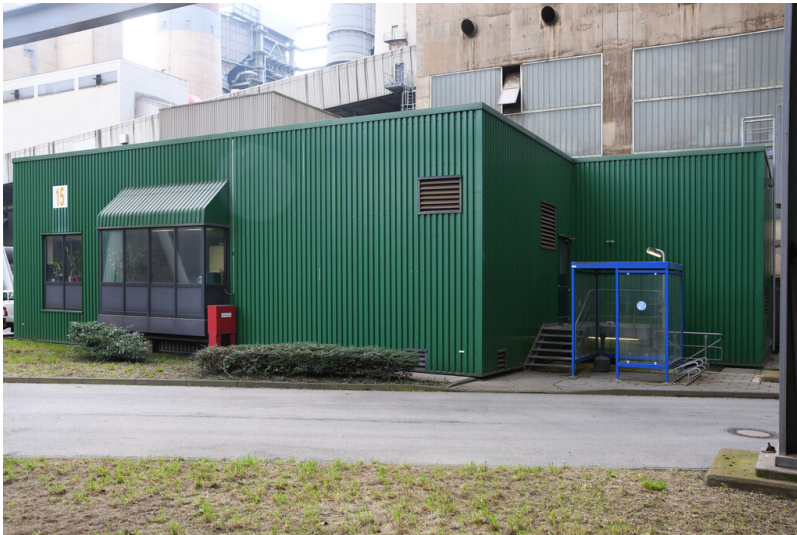
Kraftwerk Neurath: Entsorgungsleitstand, Ansicht von Nordwesten; Foto: 12.09.2023 Fotograf/Urheber: Dr. Norbert Gilson
