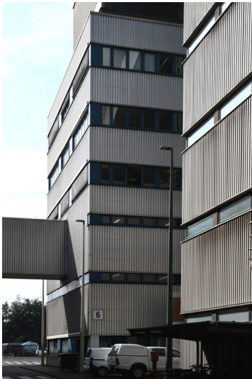
Kraftwerk Neurath: Multifunktionsgebäude, Ansicht von Nordosten; Foto: 12.09.2023 Fotograf/Urheber: Dr. Norbert Gilson
