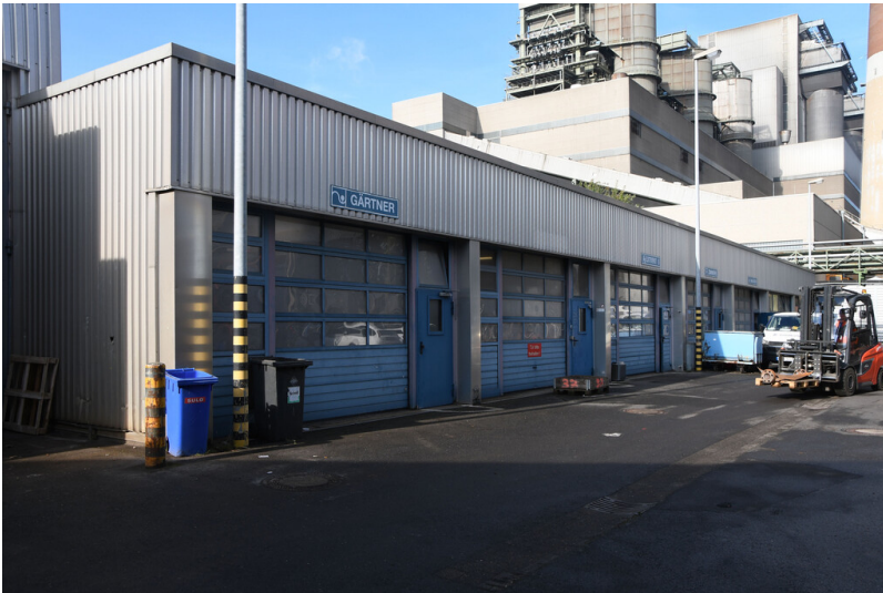
Kraftwerk Neurath: Bauhof Stützpunkt, Hallenteil, Ansicht von Osten; Foto: 12.09.2023 Fotograf/Urheber: Dr. Norbert Gilson
