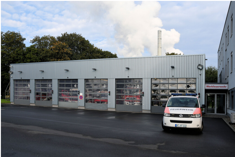
Kraftwerk Neurath: Neue Feuerwache, Fahrzeughalle, Ansicht von Südosten; Foto: 12.09.2023 Fotograf/Urheber: Dr. Norbert Gilson
