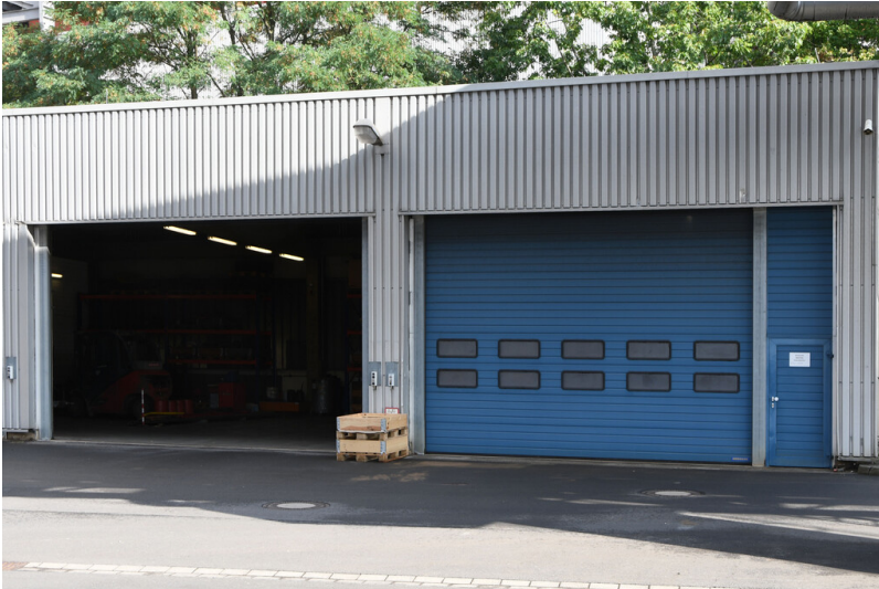
Kraftwerk Neurath: Feuerwache, Gebäudedetail Garagen, Ansicht von Süden; Foto: 12.09.2023 Fotograf/Urheber: Dr. Norbert Gilson
