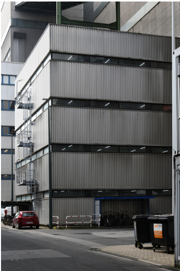
Kraftwerk Neurath: Waschkaue A/C, Ansicht von Nordosten; Foto: 12.09.2023 Fotograf/Urheber: Dr. Norbert Gilson
