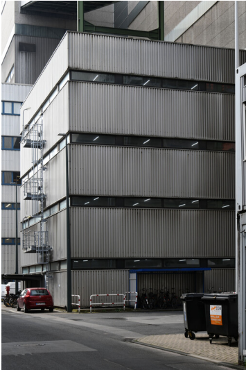
Kraftwerk Neurath: Waschkaue A/C, Ansicht von Nordosten; Foto: 12.09.2023 Fotograf/Urheber: Dr. Norbert Gilson
