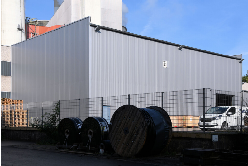
Kraftwerk Neurath: Freilager, Hallenbau, Ansicht von Südosten; Foto: 12.09.2023 Fotograf/Urheber: Dr. Norbert Gilson
