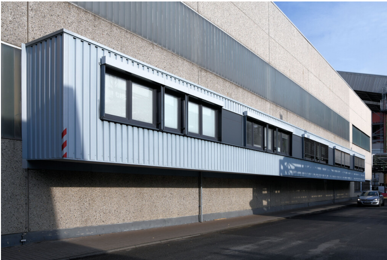
Kraftwerk Neurath: Verwaltungs-/Werkstattgebäude, Werkstatttrakt, Ansicht von Süden; Foto: 12.09.2023 Fotograf/Urheber: Dr. Norbert Gilson
