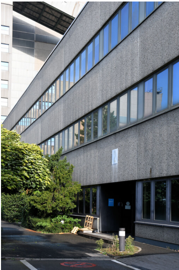
Kraftwerk Neurath: Verwaltungs-/Werkstattgebäude, Verwaltungstrakt, Eingang, Ansicht von Südosten; Foto: 12.09.2023 Fotograf/Urheber: Dr. Norbert Gilson
